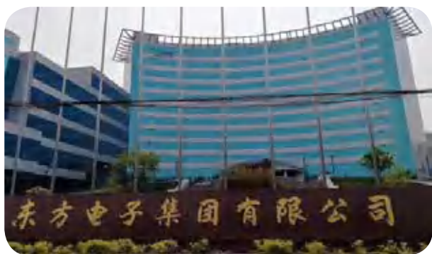
▲ 海尔—烟台东方电子冷站优化提升项目
