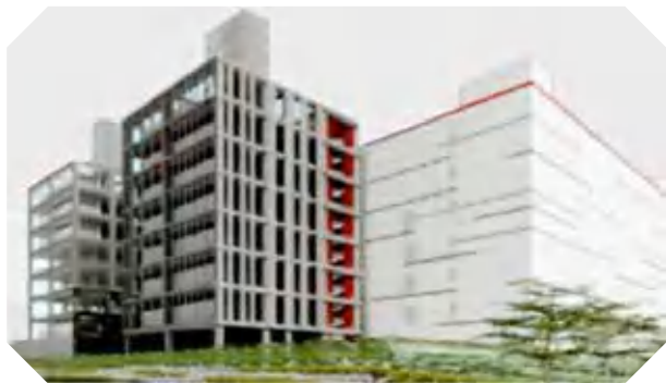
▲ 克莱门特捷联—新加坡电信数据中心冷源机房建设项目
