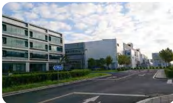
▲ 海尔—腾讯青浦云计算中心 103 扩容机房项目
